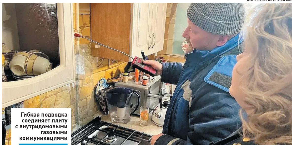
**Гибкая подводка соединяет плиту с внутридомовыми газовыми коммуникациями**
